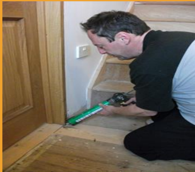
Повишаване въздухоплътността на контактния слой
