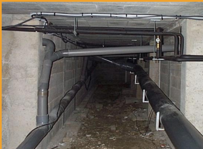
Технически канал под сградата
