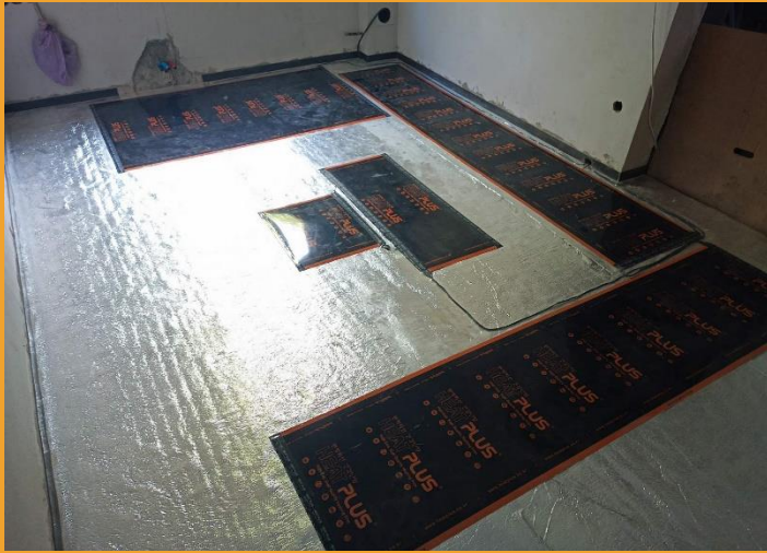
Полагане на подово отопление
