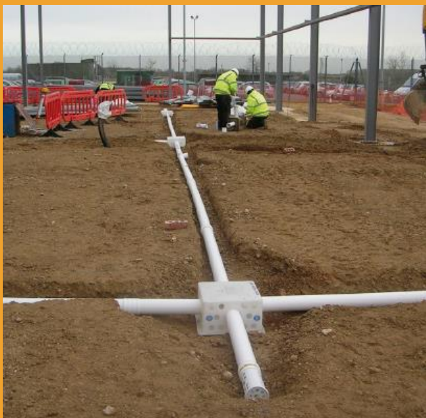
Монтиране на радонови шахти
