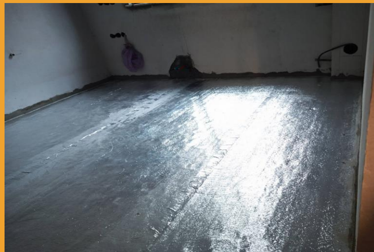
Готов под за полагане на подово отопление
