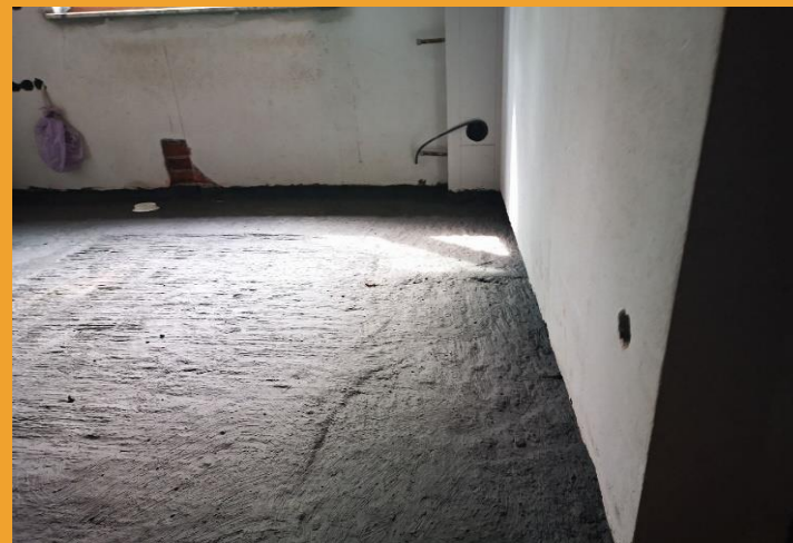
Полагане на антирадонова хидроизолация върху подовата плоча
