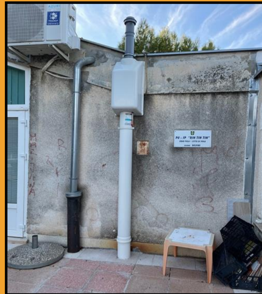
Понижаване на налягането в под контактната конструкция
