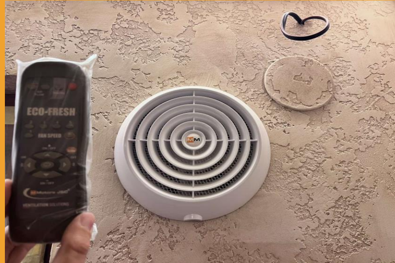
Монтиране на вентилатори с рекуператор
