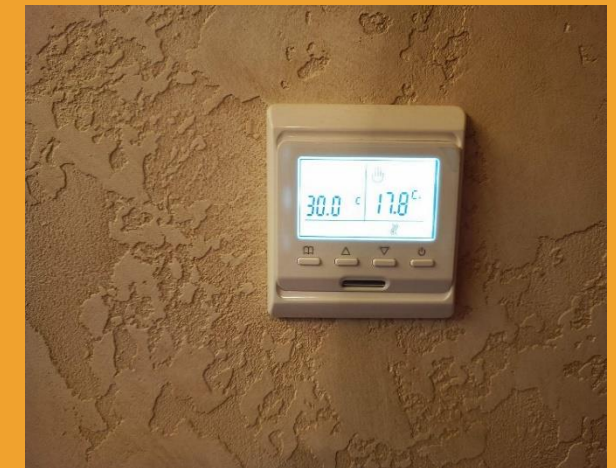
Инсталиране на контролер за подово отопление
