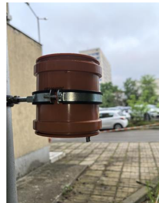
Снимка 20. Начин за монтиране на кутиите
